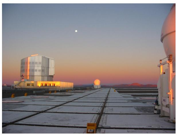
Blick über die Plattform des VLTI mit einem der vier 8.2m-Teleskope und zwei der vier Hilfsteleskope. Wird das Licht zweier Teleskope interferometrisch kombiniert, bestimmt deren projizierter Abstand das räumliche Auflösungsvermögen.
